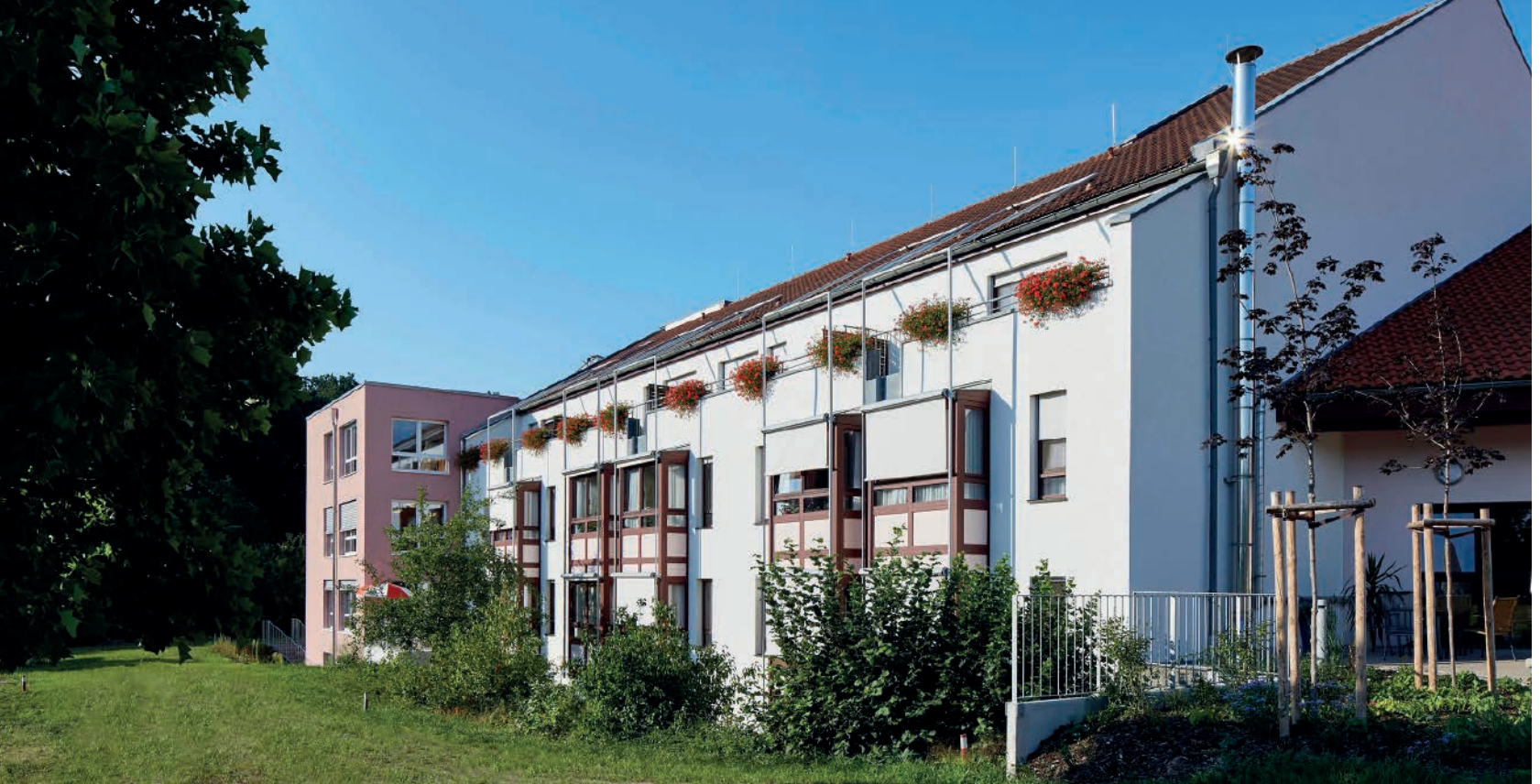
Im fränkischen Höchstadt-Etzelskirchen: Das BRK Alten- und Pflegeheim aus den 80ern wurde umfassend saniert.
