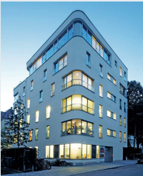
Münchener Bürogebäude – von va-Q-tec gedämmt
